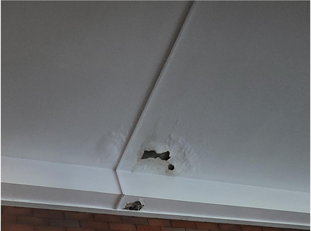
zdj. 3 Widok sufitu.
