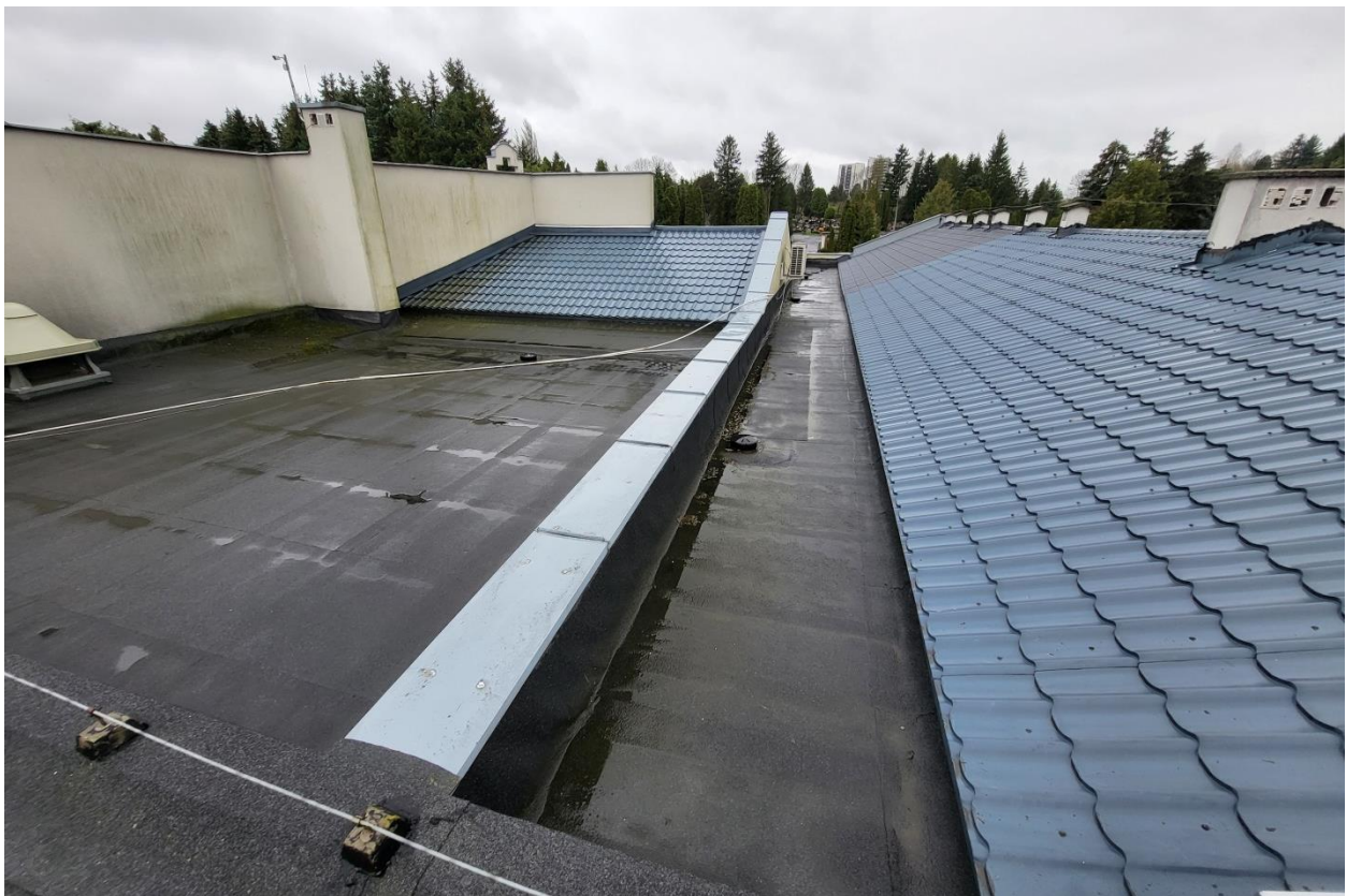
zdj. 2 Widok dachu budynku.
