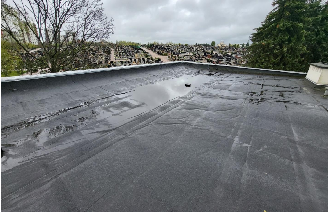
zdj. 1 Widok dachu budynku kaplicy.
