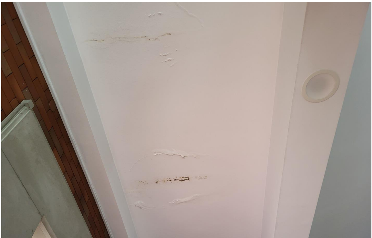
zdj. 4 Widok sufitu.
